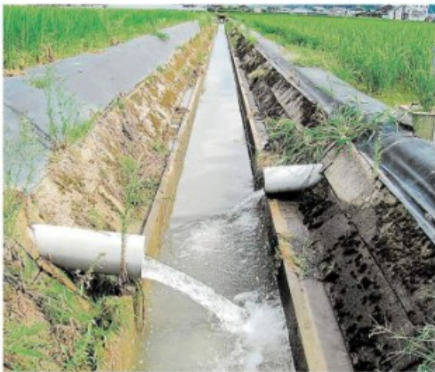
降雨時の田んぼダム(右)からの排水の様子。流量調整板の効果で通常の水田(左)より排水量が少ない。2021年7月、鯖江市川去町(県提供)
