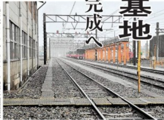
車両基地が設置されるハピラインふくいの車両管理センター＝9日、福井市花堂東1丁目
