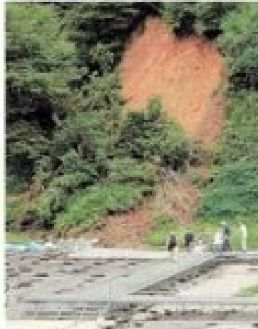
主殿跡の崩壊が起き、むき出しになっている朝倉氏遺跡の跡地。10日、福井市城戸ノ内町（朝倉氏大遺跡）
