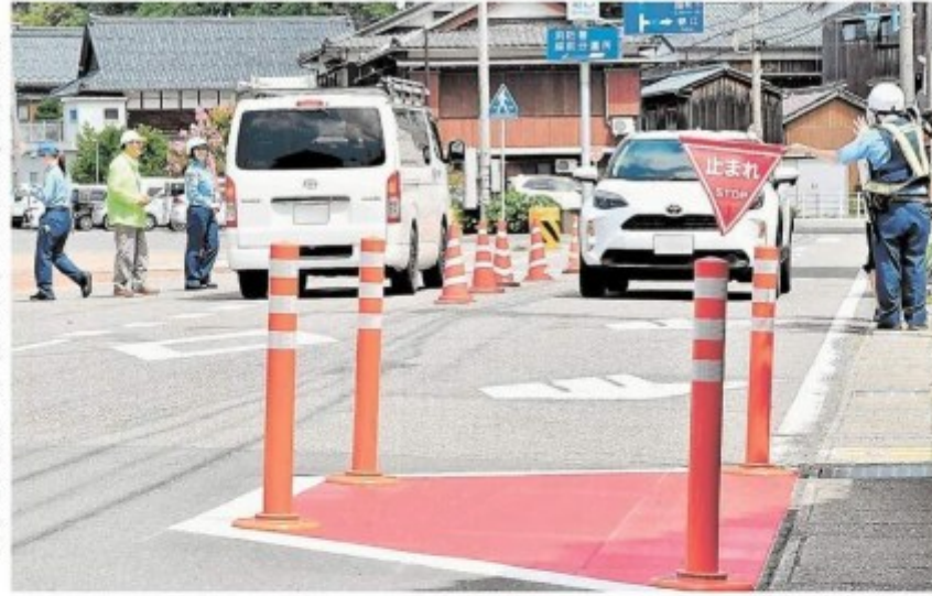
速度抑制対策として町道に新たに設置された ラバーポール(手前) 4日、越前町道口
