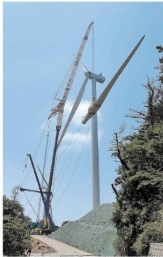
高さ104mにある回転軸にはめ込むため、クレーンでつり上げられるブレード＝6月30日、福井市養町
