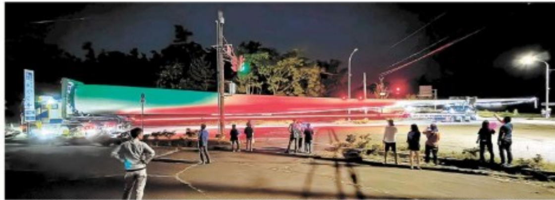
全長66.7mのブレードを載せて「道の駅みくに」前の交差点を曲がる大型トレーラー＝6月30日午後9時20分ごろ、坂井市三國町山岸
