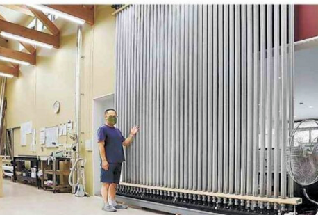
井戸水が通り、室内の空気を冷やしている79本の放熱フィンパイプ=30日、福井市石盛町のシアターハウス本社
