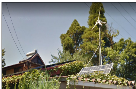
太陽電池や風力発電機を設置した佐々木宅
