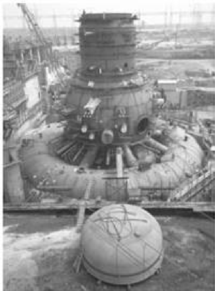
(a) 建設中の写真
