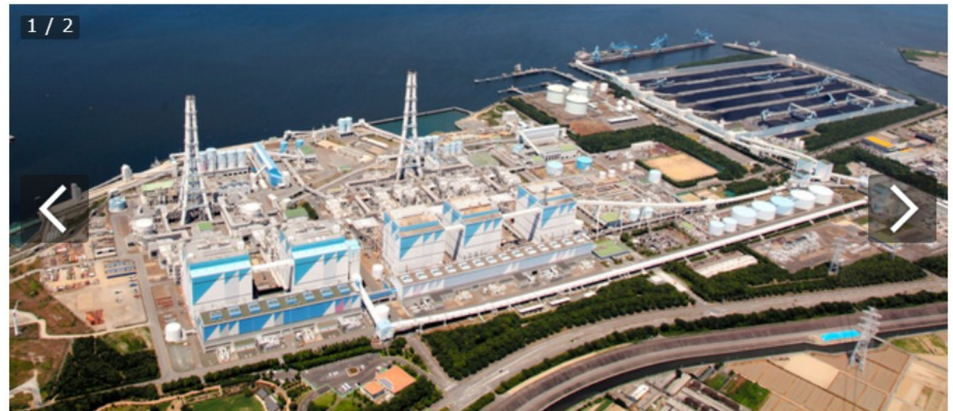
JERAがアンモニアの混焼実験を始める碧南火力発電所=愛知県碧南市、同社提供
