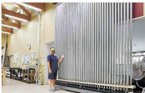
井戸水が通り、室内の空気を冷やしている79本の放熱フィンパイプ=30日、福井市石盛町のシアターハウス本社
