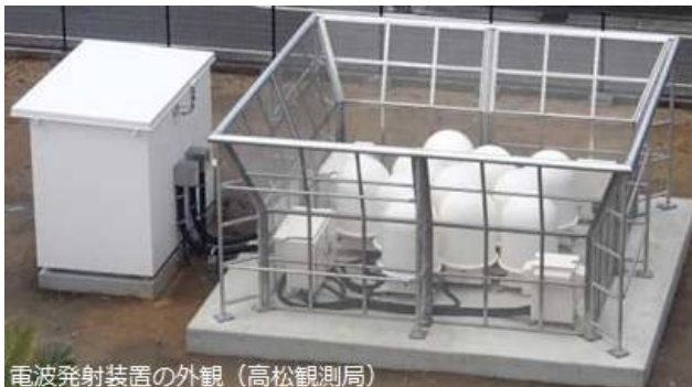
電波発射装置の外観（高松観測局）
