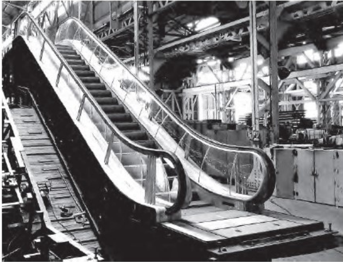
図 4.8 東京・銀座ショッピングセンター 全透明形・工場組立中（1958年）日立提供
