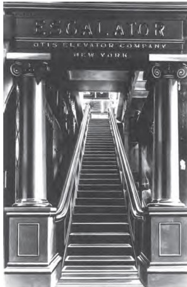
図 2.7 パリ万博出展機 踏段式自動階段（1900年） 日本オーチス提供
