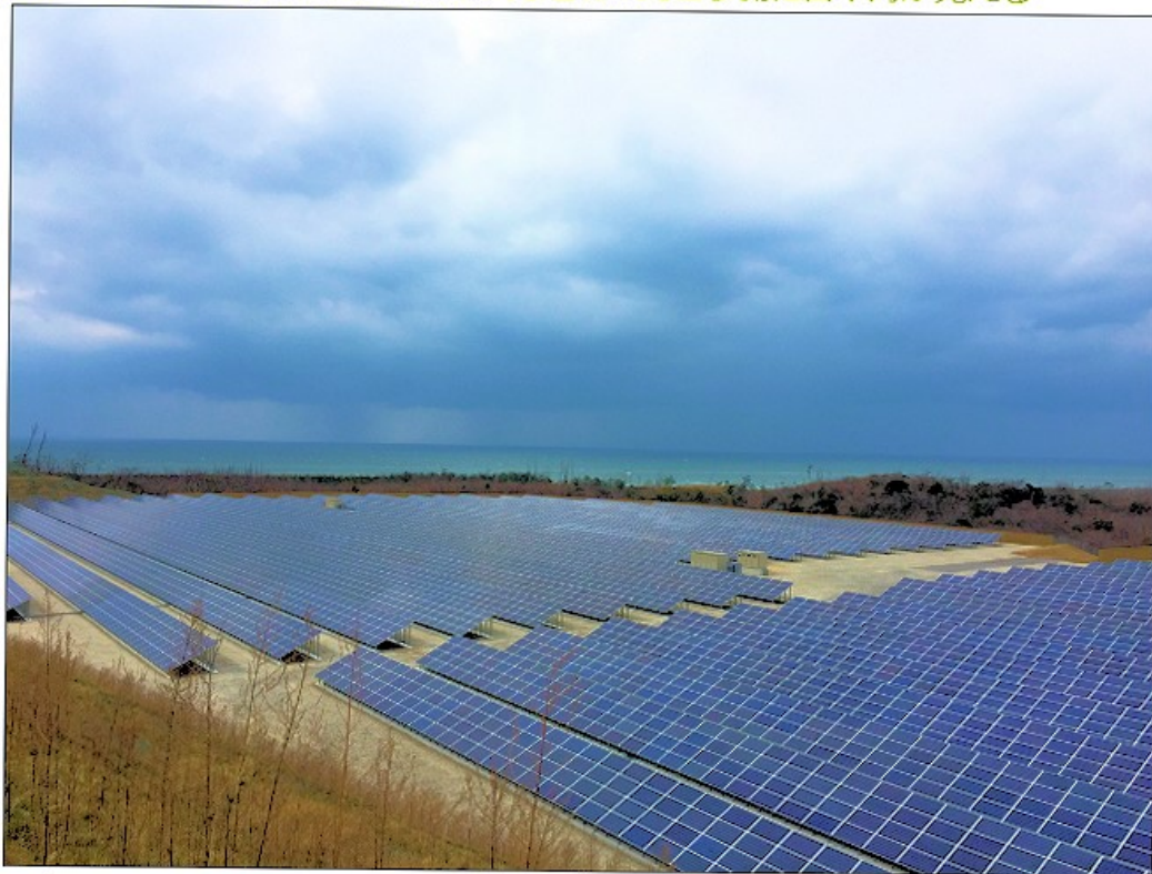
図 「石川第八発電所」の様子。発電所の向こう側に日本海が見える
