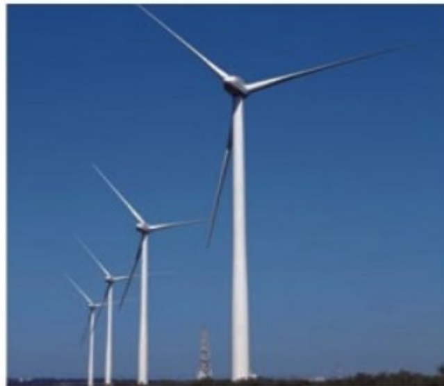
運転開始した三国風力発電所
