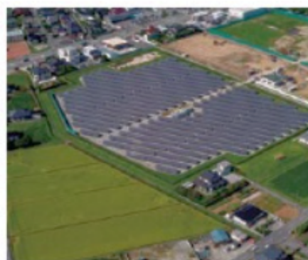
富山太陽光発電所
